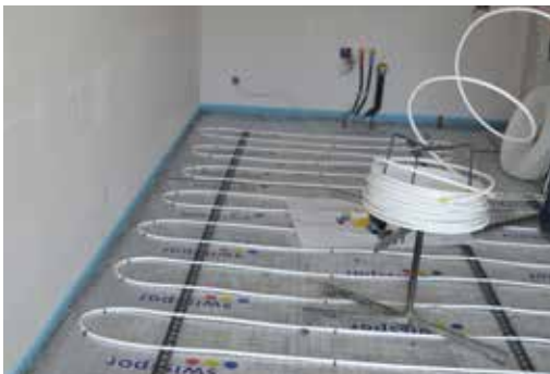
Verlegen der Heizungsrohre
