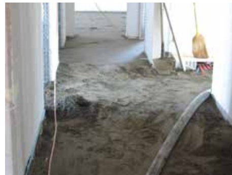
Giessen des Estrichs
