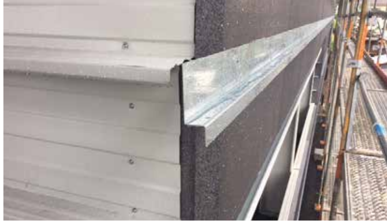
Horizontal UK-Stahlprofil auf swissporLAMBDA Cassette montiert (verschraubt)
